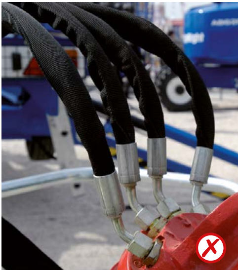
Abb. 21 Falsche Schutzschlauch-Montage: Schutzschläuche sind in die Armaturen mit eingebunden
